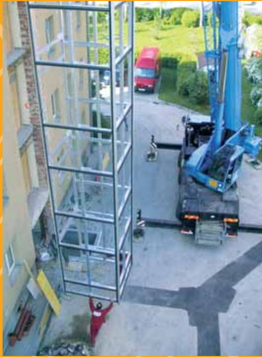
Stahlschachtmontage
