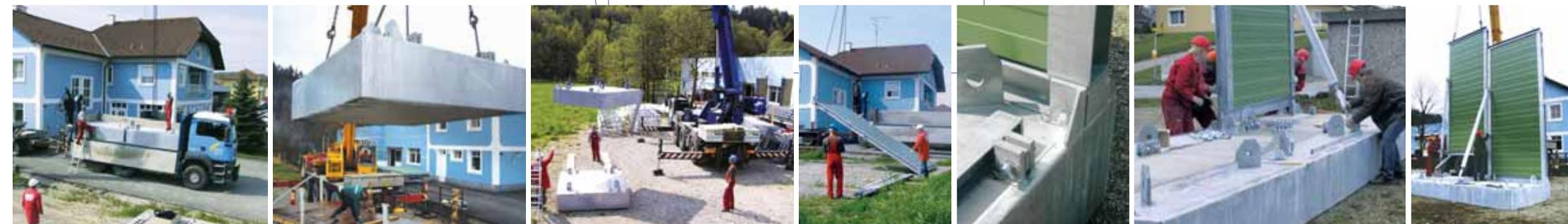
Für die Dauer der Lärmquelle verbleibt der mobile Lärmschutz von LEBAU auf dem Aufstellort. Nach Beendigung der Lärmbelastung kann dieser mit geringem Aufwand wieder demontiert werden. Die Einzelteile werden zwischengelagert und wiederverwendet.
